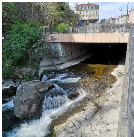
Figure 5 : sortie de la couverture de la Deûme
